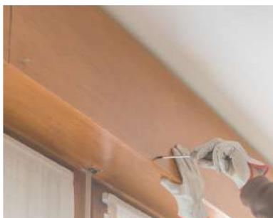
Pour un volet type traditionnel dévissez les vis de la face avant du coffre en bois à l'aide d'un tournevis.
