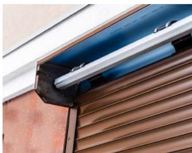
Pour un volet type rénovation dévissez les vis de la face avant du caisson aluminium à l'aide d'un tournevis .
