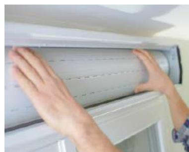
Pour un volet type bloc-baie déclipsez délicatement la face avant du caisson en PVC à l'aide d'un tournevis .
