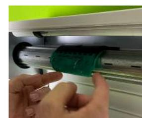
Selon le modèle d'attache-tablier de votre volet, il vous faudra libérer la liaison mécanique entre les attaches-tablier et le tube d'enroulement, en les dévissant, les déclipsant ou peut-être même les deux.
